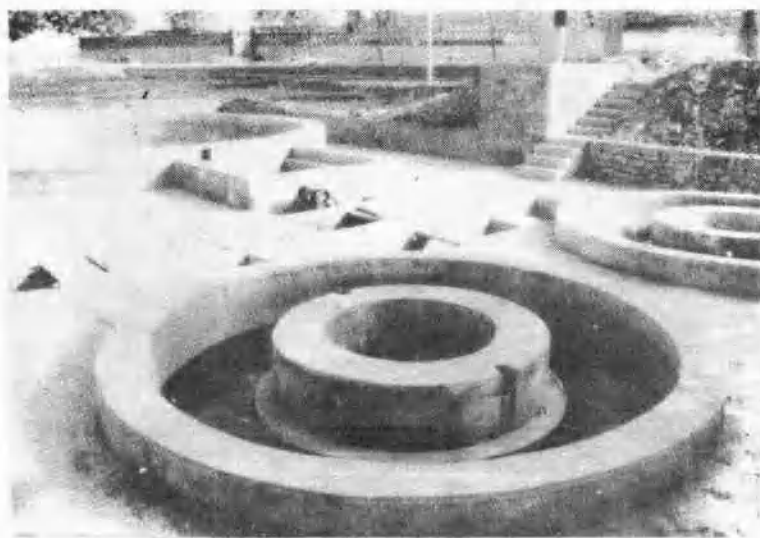
门楼水库鱼种场孵化设备
