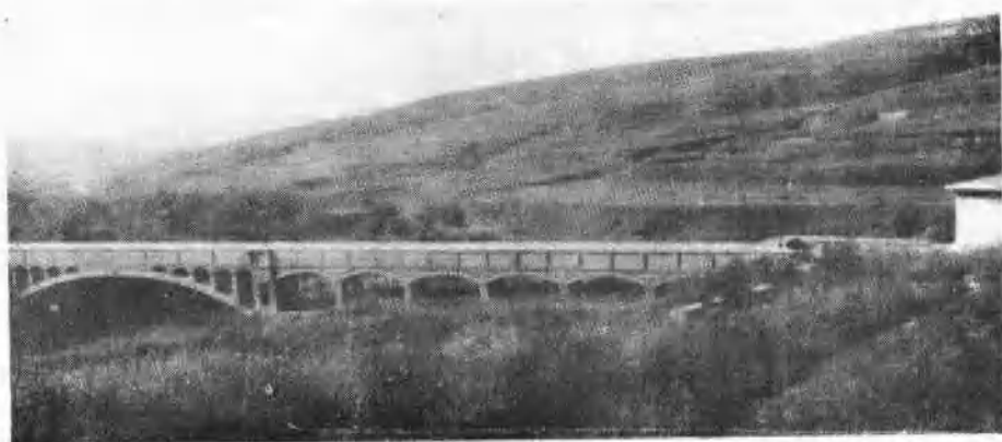
磁山水库输水工程
