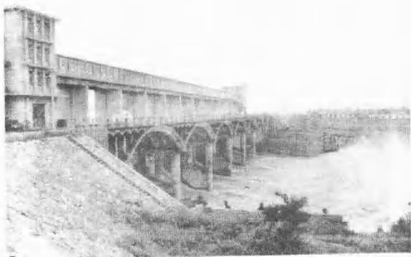
门楼水库溢洪闸
