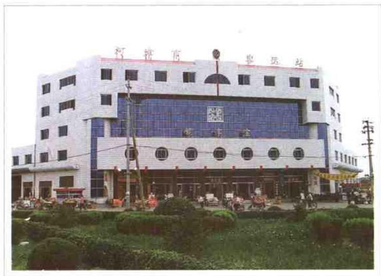
投入使用的国家B级河津客运站大楼
