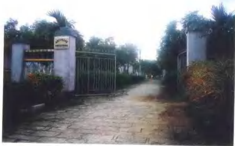
兴隆35KV变电站
