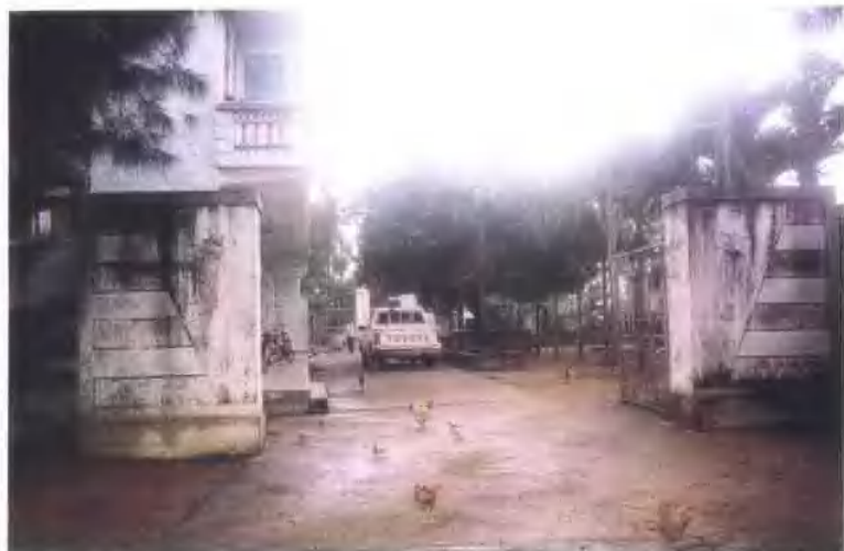
乐来35KV变电站
