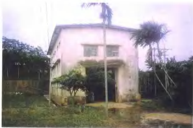
万宁水库坝后电站
