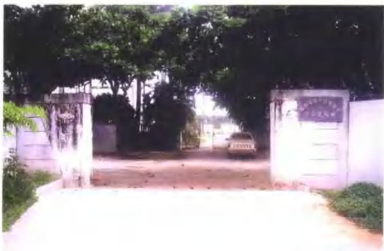
万宁110KV变电站
