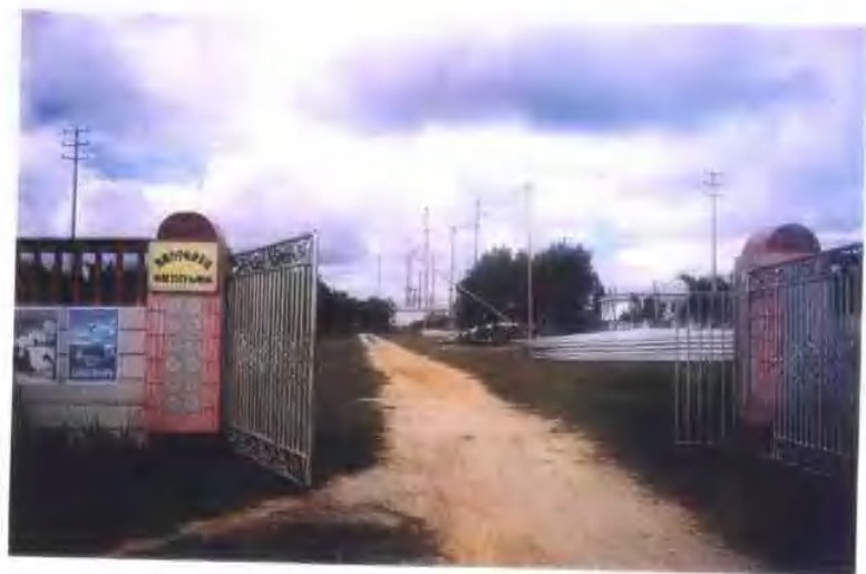
东星35KV变电站
