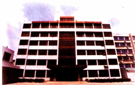
济宁市统计局办公大楼
