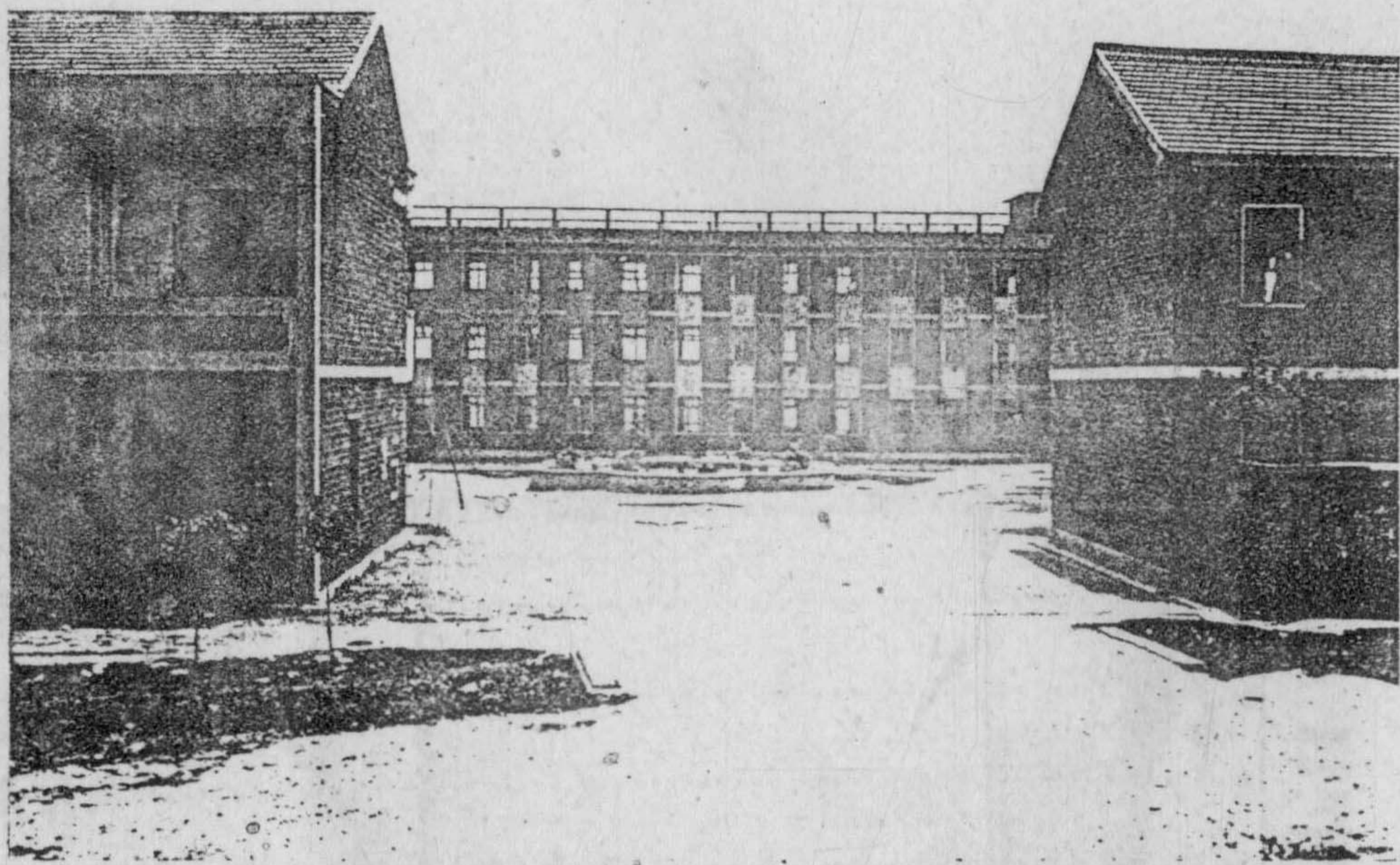
永安镇中心小学全景
