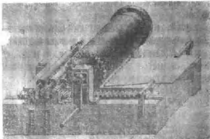
为了“游击办报”，牛步锋同志苦心钻研。1940年制成铁质轻便印刷机；1943年制成木质轻便铅印机，人背肩扛就可运走。图为木质印刷机设计图。
