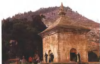
四门塔 Simen Tower.
