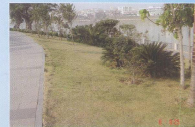
■ 东江大堤整治工程
