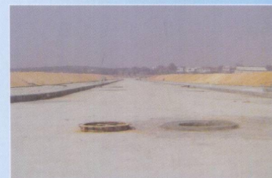
■ 松山湖大道9号路(在建工程)
