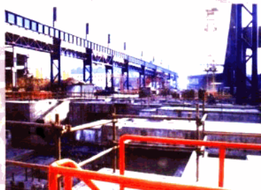
建设中的超薄带钢项目
