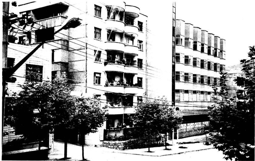
贵州省烟草公司息烽县公司办公楼
