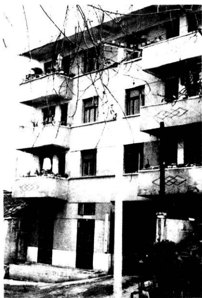
永阳区烟叶站办公楼
