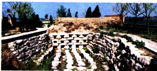
齐故城排水道
