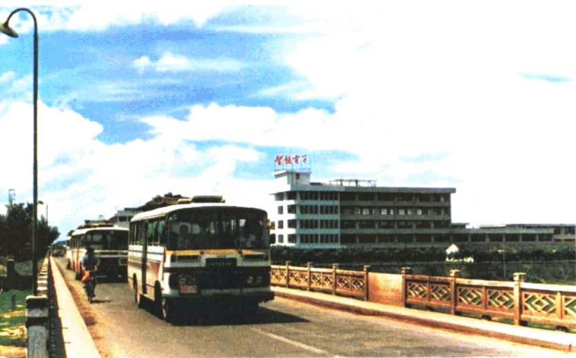
广湛线西南公路桥
