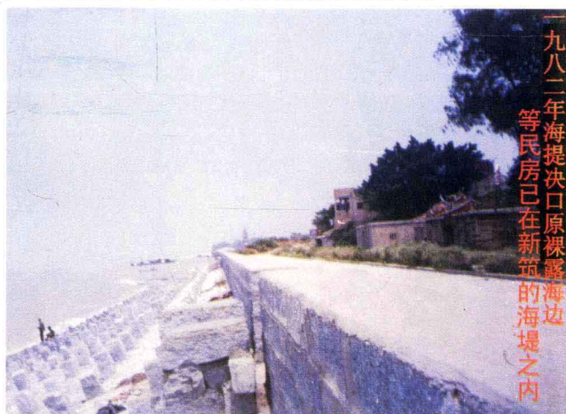
2001年 已完成新建 250米海堤。
