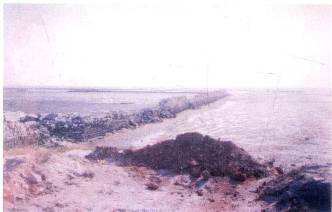
未完工 的新建八百 亩东港围垦 工地。(希望 后继有人)
