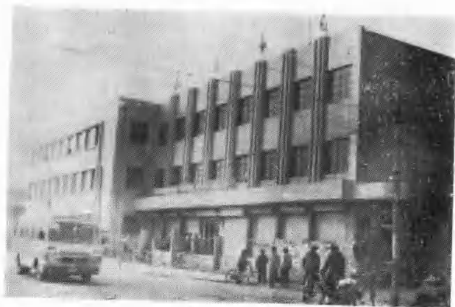
邮电营业大楼
