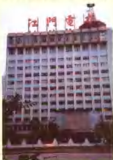
江门市电力局办公大楼
