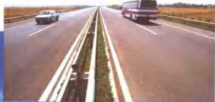
济青高速公路昌乐段 Ji Qing express highway
