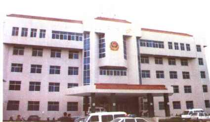
三建承建的公安局办公楼 (省优工程)
