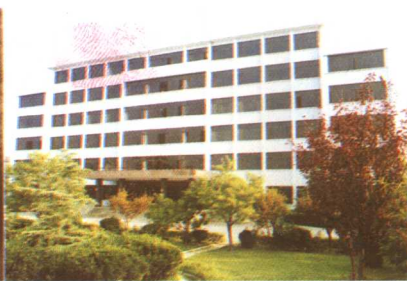
二建承建的县委办公楼 (市优工程)
