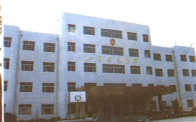
一建承建的工商局办公楼 (省优工程)
