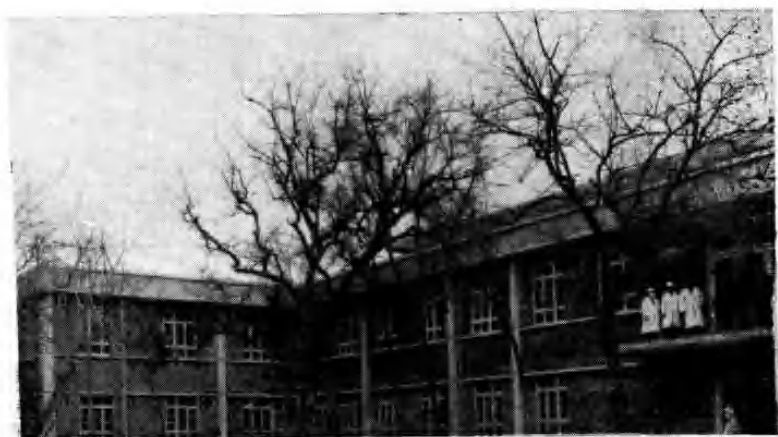
新建病房大楼
