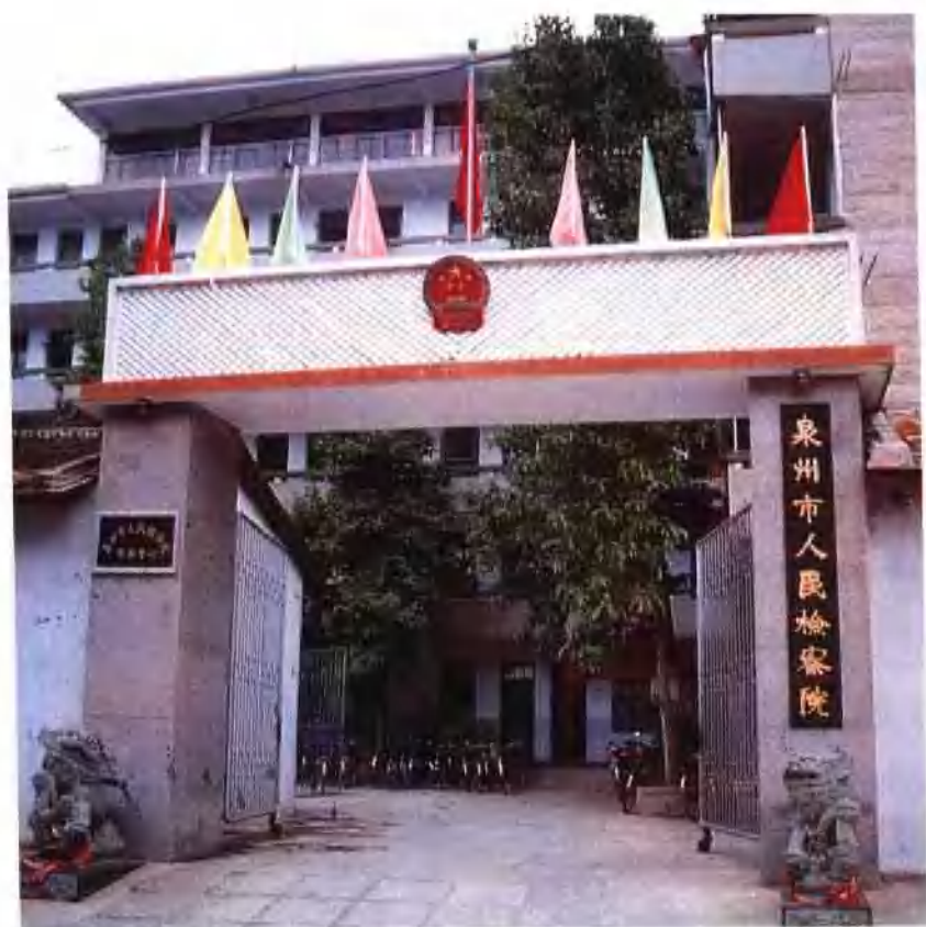
市人民检察院办公地点：鲤城区新府口 48 号。
