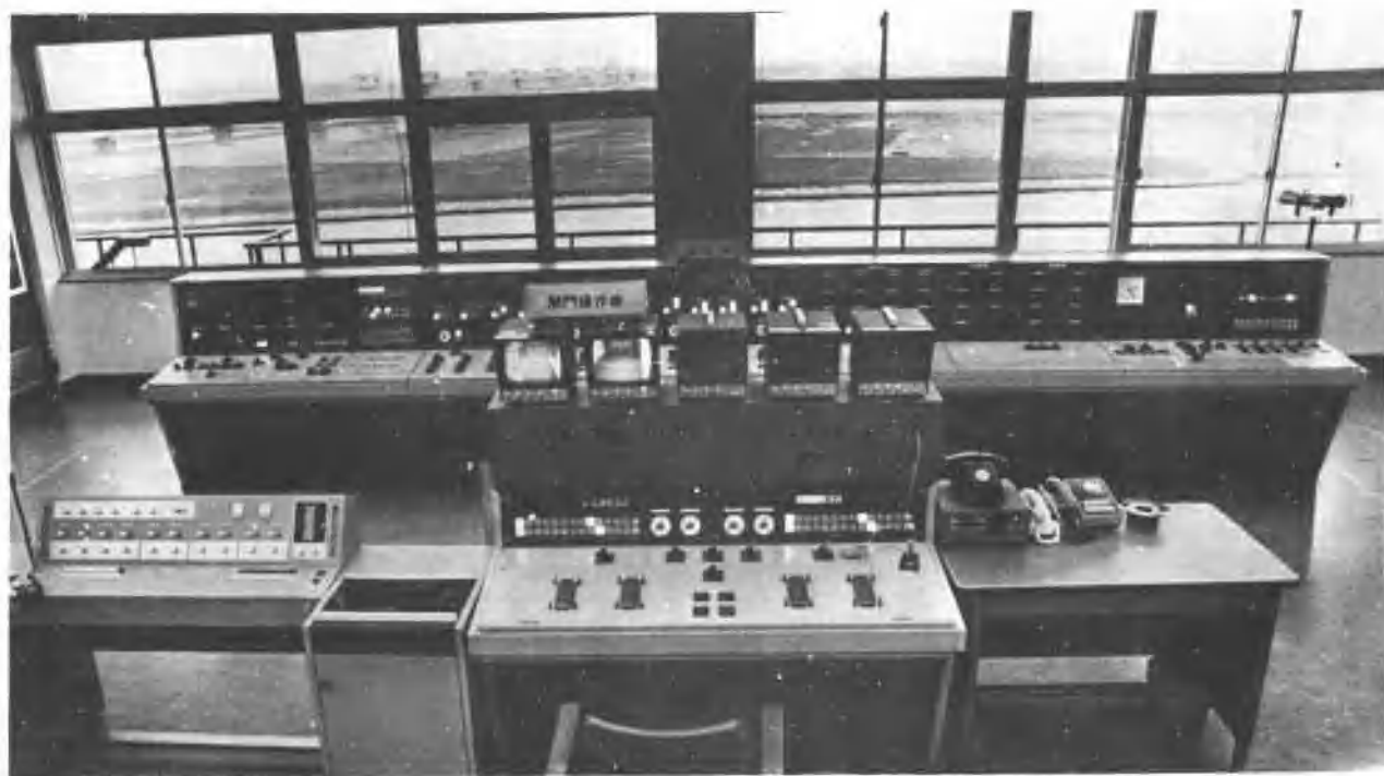
▼由现场送来的氢离子浓度以及水位等数据，经过电子计算机处理以后，片刻之间以数字方式与闸门的开关时间等一起显示出来。
