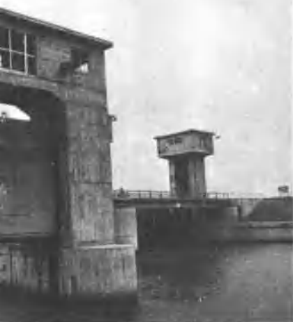
▲黑部川的河堰，长54.7米，装有径20米的水门两座和宽6.4米的闸门一座。为了保证渔船的安全行驶，设有红蓝双色指示灯，并由集体天线电视进行监视，以策万全。
