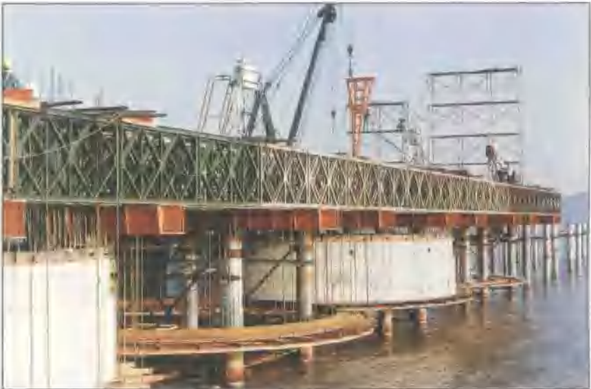
建设中的南沙深水码头。
