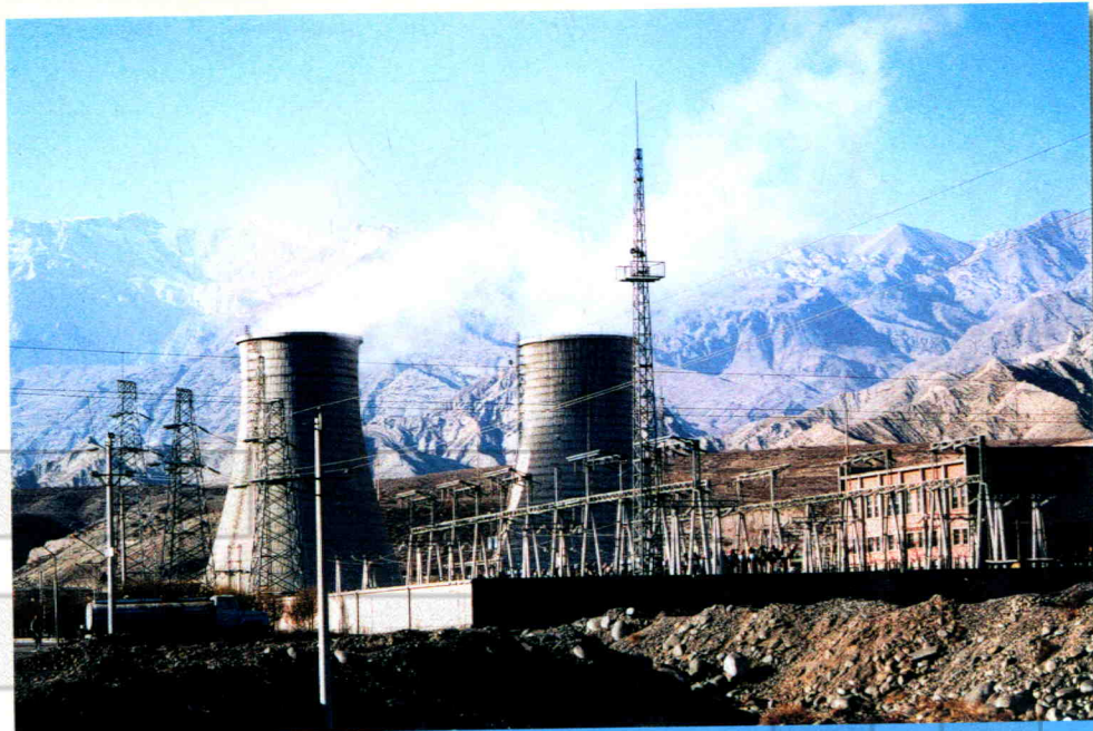
建设中的拜城电厂三期工程 (刘建江)
