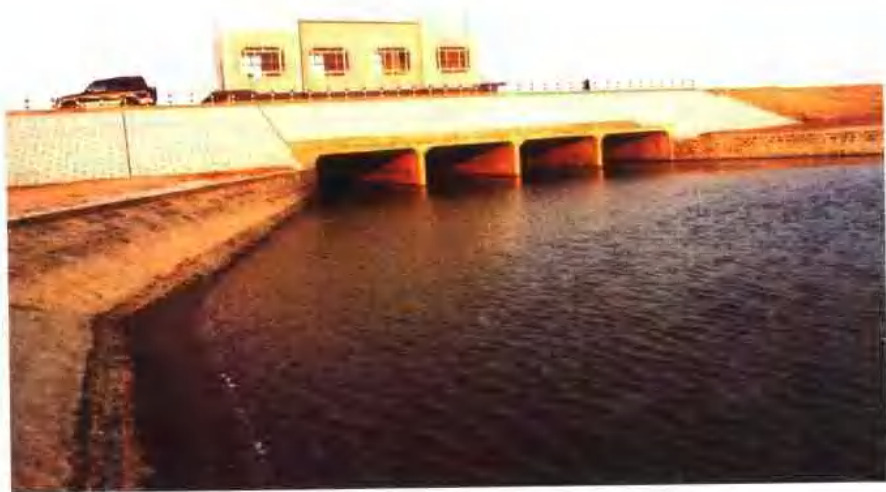
海堤工程 明港挡潮闸
