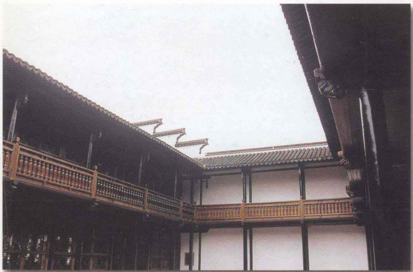
修复后的转盘楼前楼
