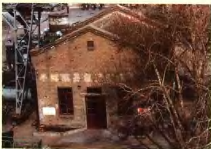
50 年代第一变电站的配电室旧址
