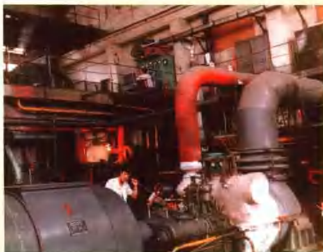
蔚县南留庄发电厂车间
