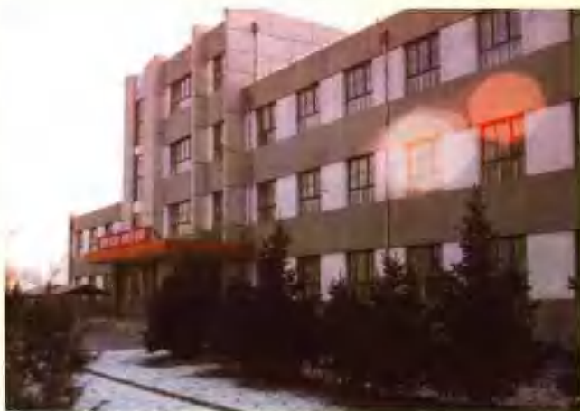
张家口供电局超高压工区
