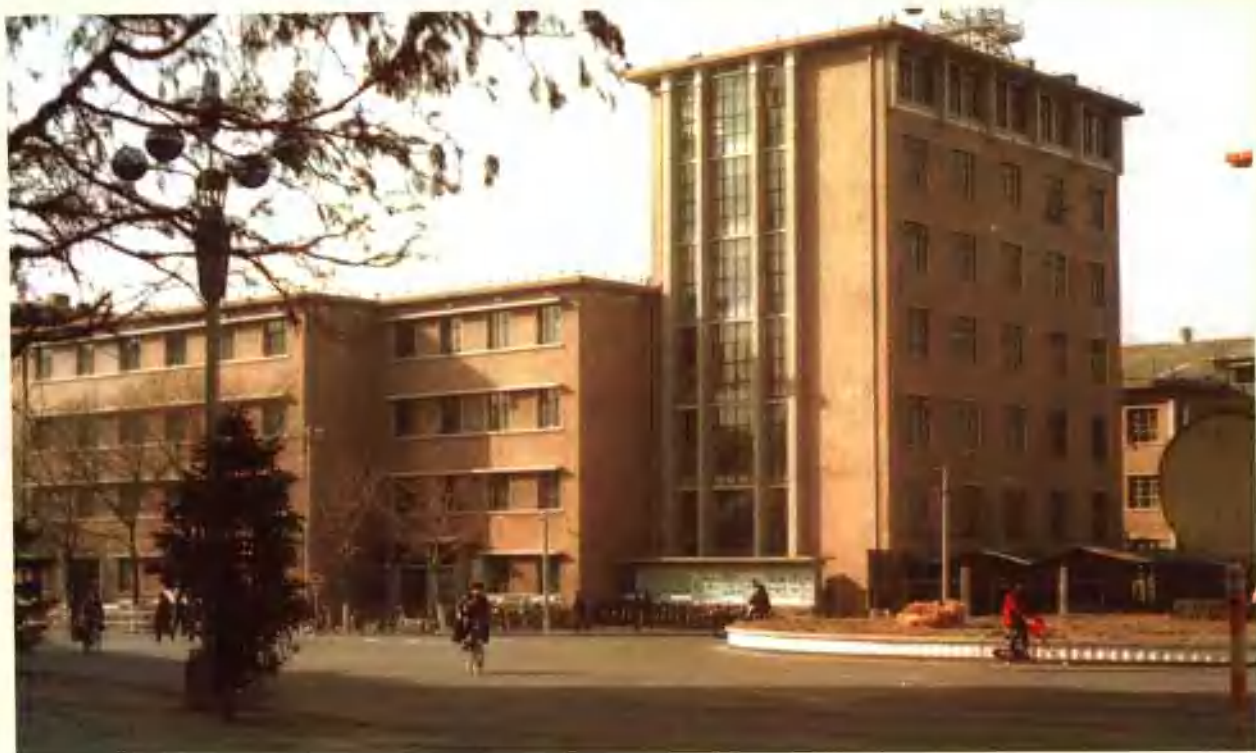
张家口供电局机关办公楼△
