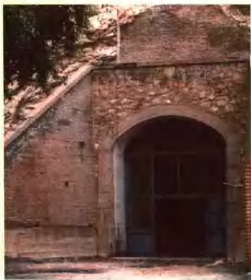
南马庄发电厂车间洞口
