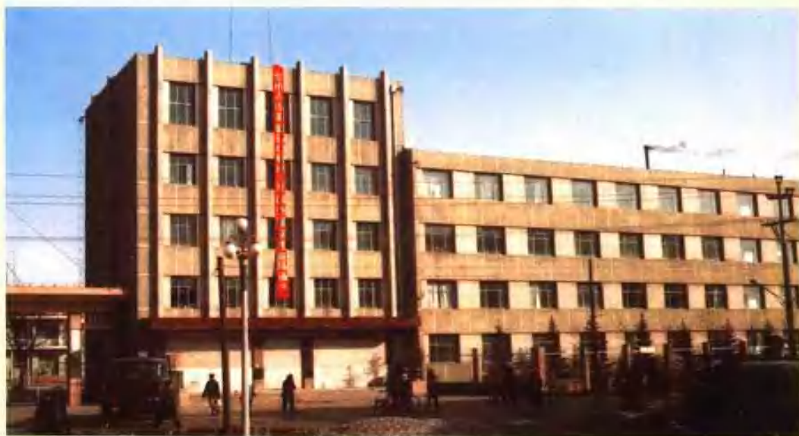
张家口供电局下花园供电所
