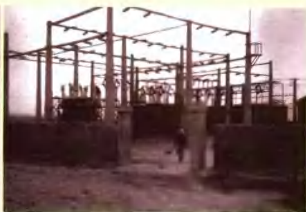
宣化小东门外 33 千伏变电站（1947）
