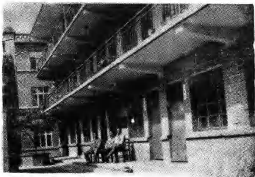
内乡县卫生局大楼
