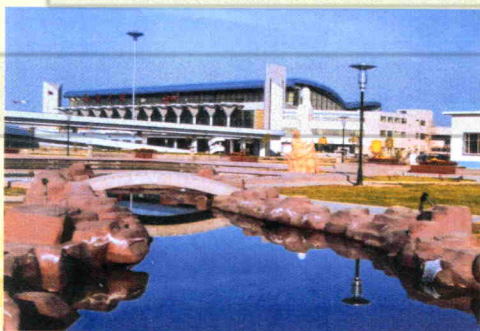
▲ 2001年12月16日，乌鲁木齐机场改扩建二期工程通过国家验收（摄影：衡亚平）
