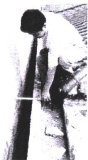
纠偏施工前的情况
