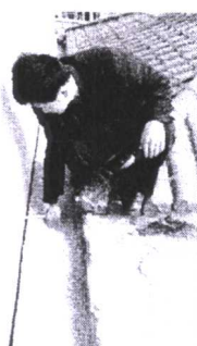
纠偏施工后的情况
