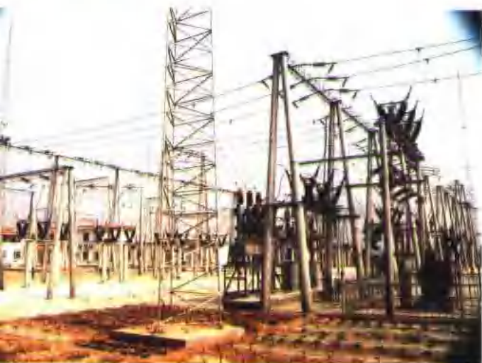
▲1997年新建的无人值守功能的变电站户外装置及自动化系统▲
