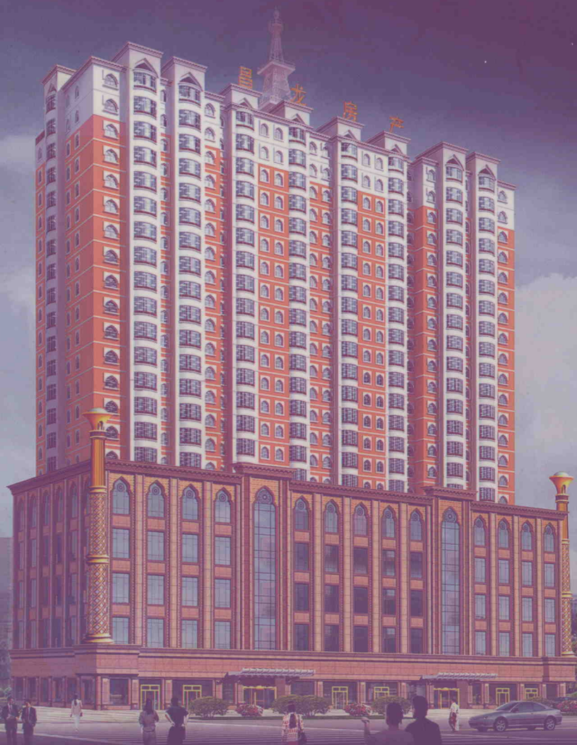
在建的商铺高层昌龙大厦
