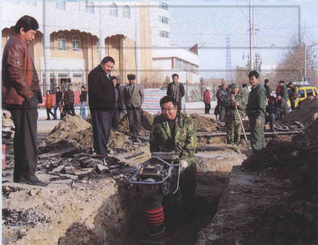
二环路管路抢修
