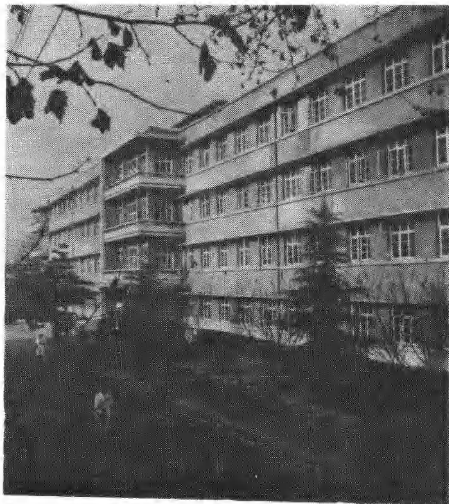
这是1979年落成并投入使用的病房大楼一角。
