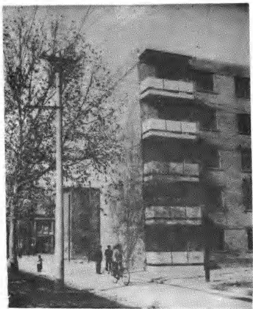
新建职工宿舍大楼一角
