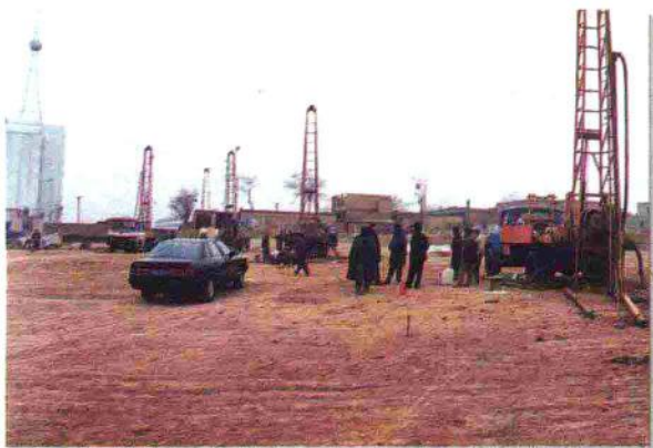
工程地质勘察现场
