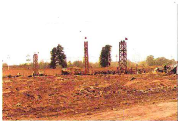
基桩工程施工现场
