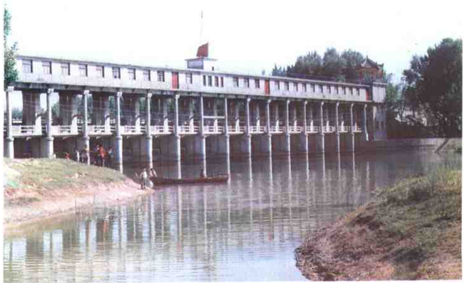
沱河张桥节制闸
