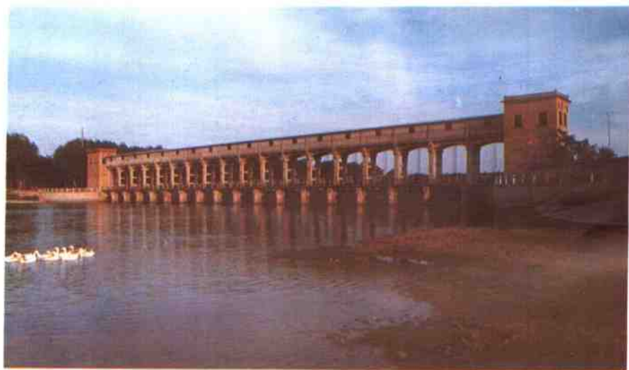
大沙河包公庙节制闸
