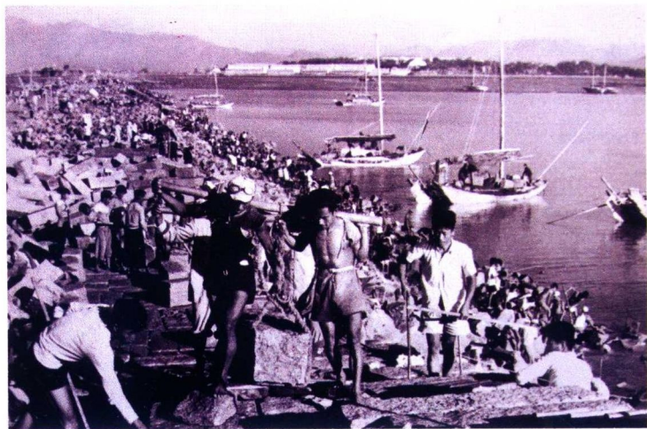
1955年高集海堤建设场面
