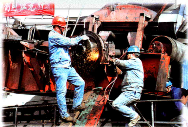
斗轮机检修现场
