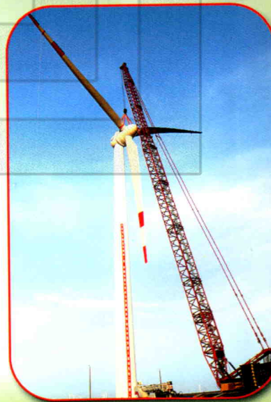
华能新疆三塘湖二场一期1500风电机组第一吊
