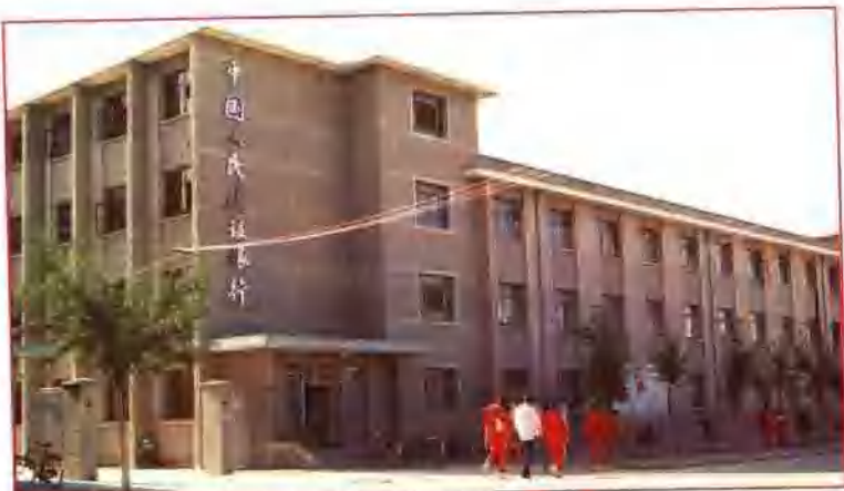
中国人民建设银行庆阳地区中心支行办公楼
