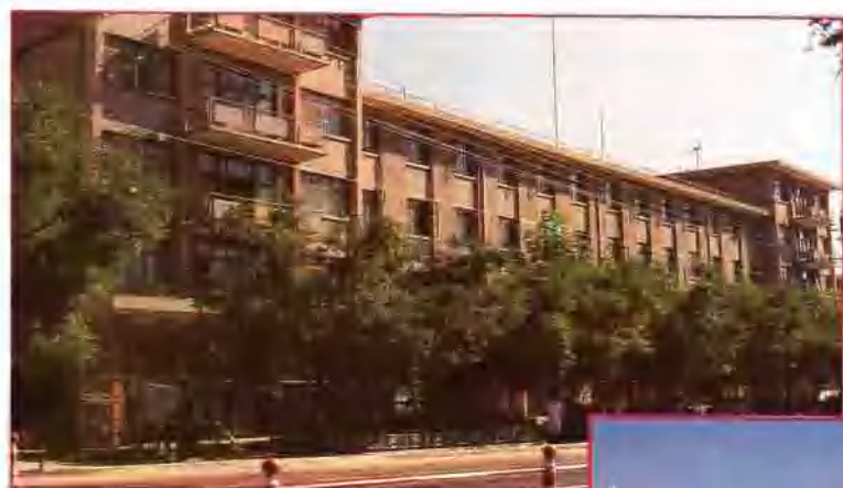
中国农业银行庆阳地区中心支行办公楼
