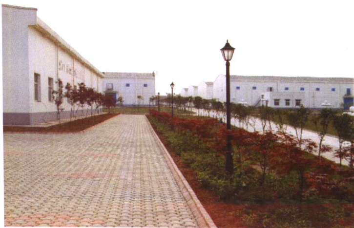
铜梁国家粮食储备库库区一隅
