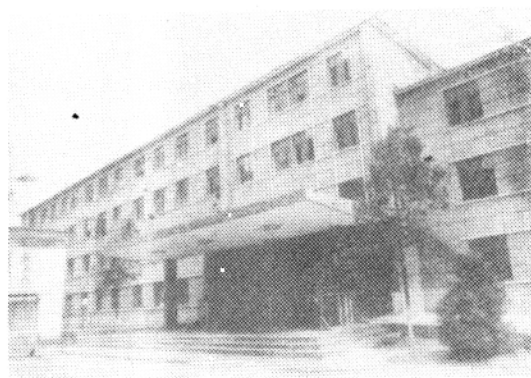
高城县人民医院病房楼
