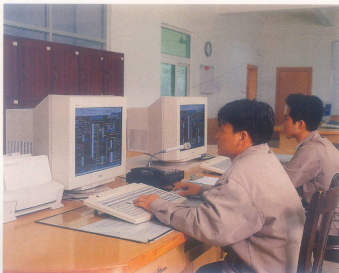
双氧水总控制室
