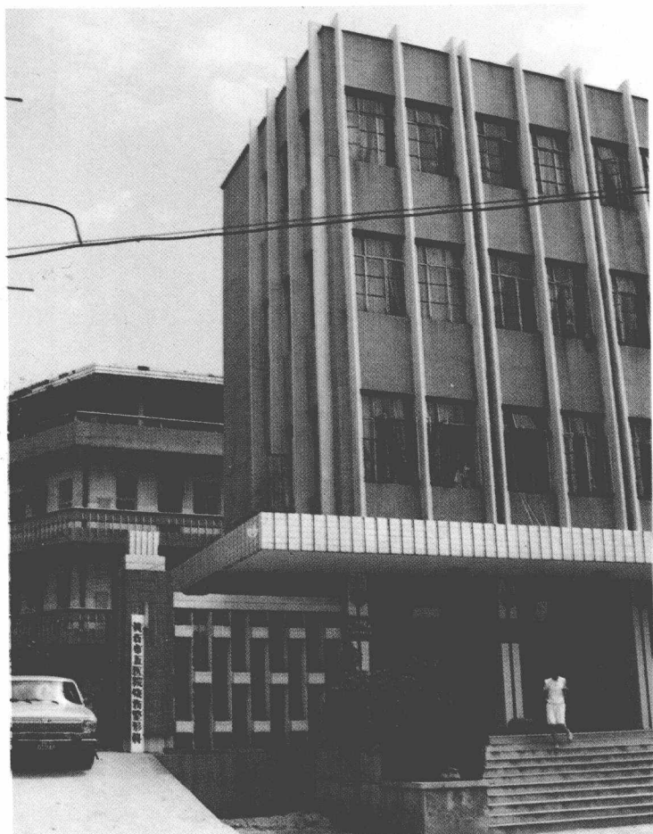
黄石市五医院烧伤 整形科大楼
