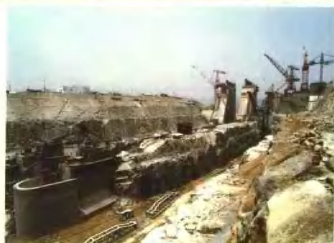
临时船闸、升船机初具规模
