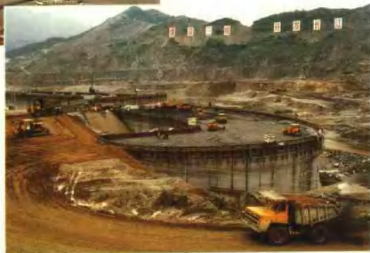
纵向围堰碾压混凝土施工。
