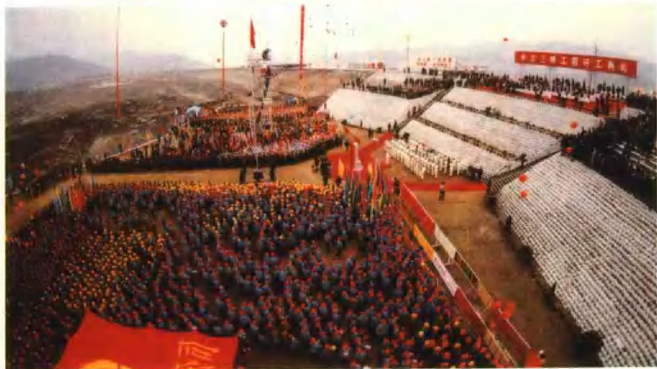
1994年12月14日，长江三峡工程开工典礼大会现场。
