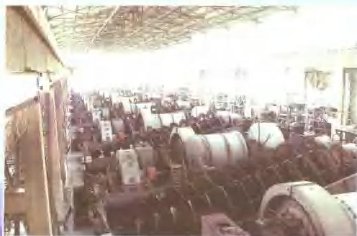
▲ 2004年，矿业公司选矿厂阶段选工业试验取得成功。改造后，铁精矿品位由52.5%提高到54.2%，台时处理量提高15%—20%。图为即将投入改造的15个球磨系统。
