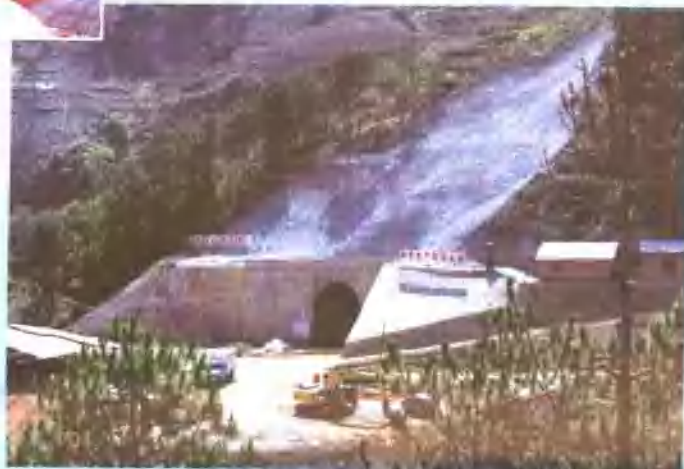
▶ 截止2004年底，白马铁矿一期工程完成投资1.28亿元。图为由攀钢冶建特种公司负责施工的1600主平硐工程。
