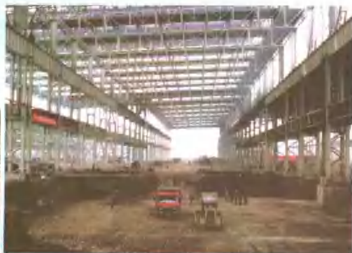
▲正在建设的攀成钢340连轧管工程。
