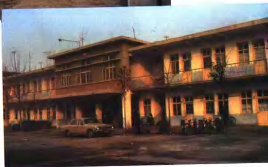
▶ 木石县分院门诊楼。
