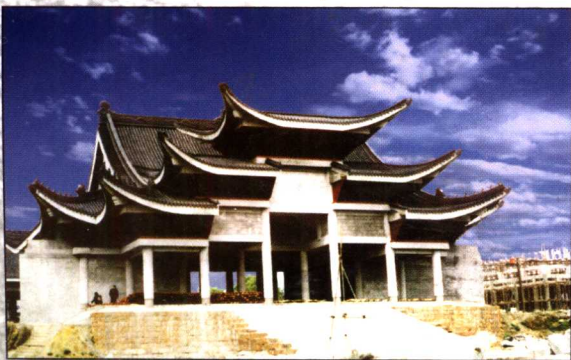
正在修建中的天王殿
