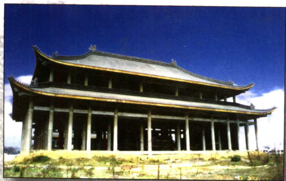
正在修建中的大雄寶殿
