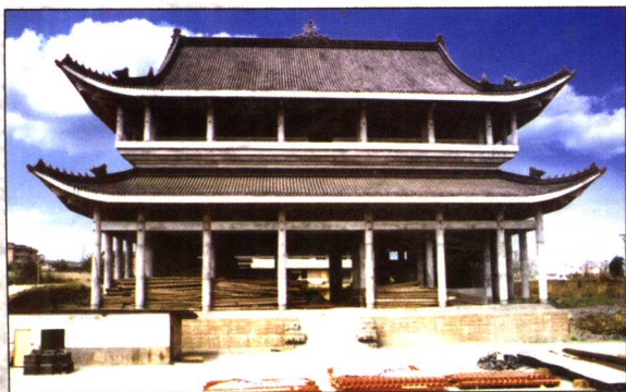
正在修建中的觀音殿
