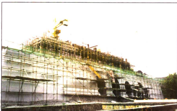
正在修建中的引門（伽藍殿）
