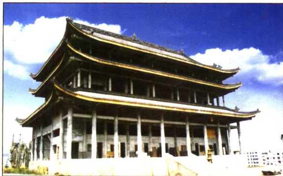
正在修建中的藏經樓
