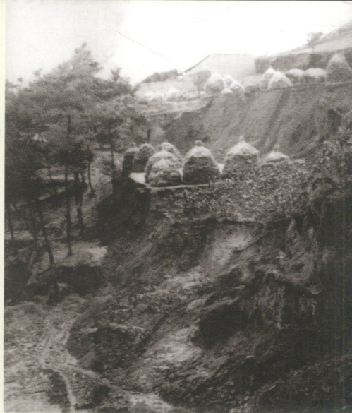
石堡乡阳坡村山体滑坡,一个麦场塌成高低三层,有五户人家房屋倒塌,村民徐进庄家房屋倒塌压死2人,重伤3人,村民们露宿野外。
