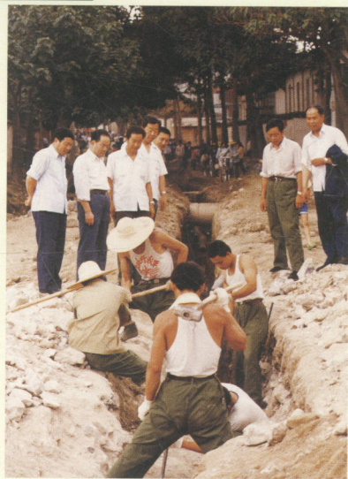
5254 部队在西和执行公路 抢修救灾任务。图为在县城街道 安装管道、硬化路面。
