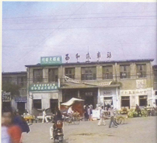
原天水运输公司西和汽车站
