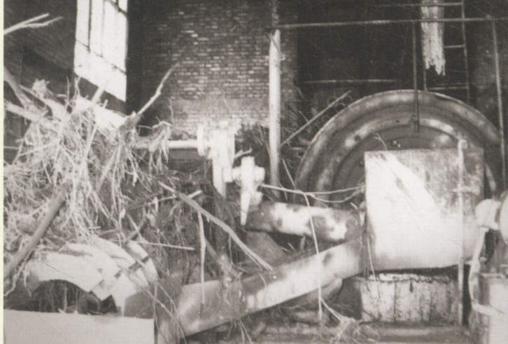
邓家山铅锌矿水毁后的选矿车间
