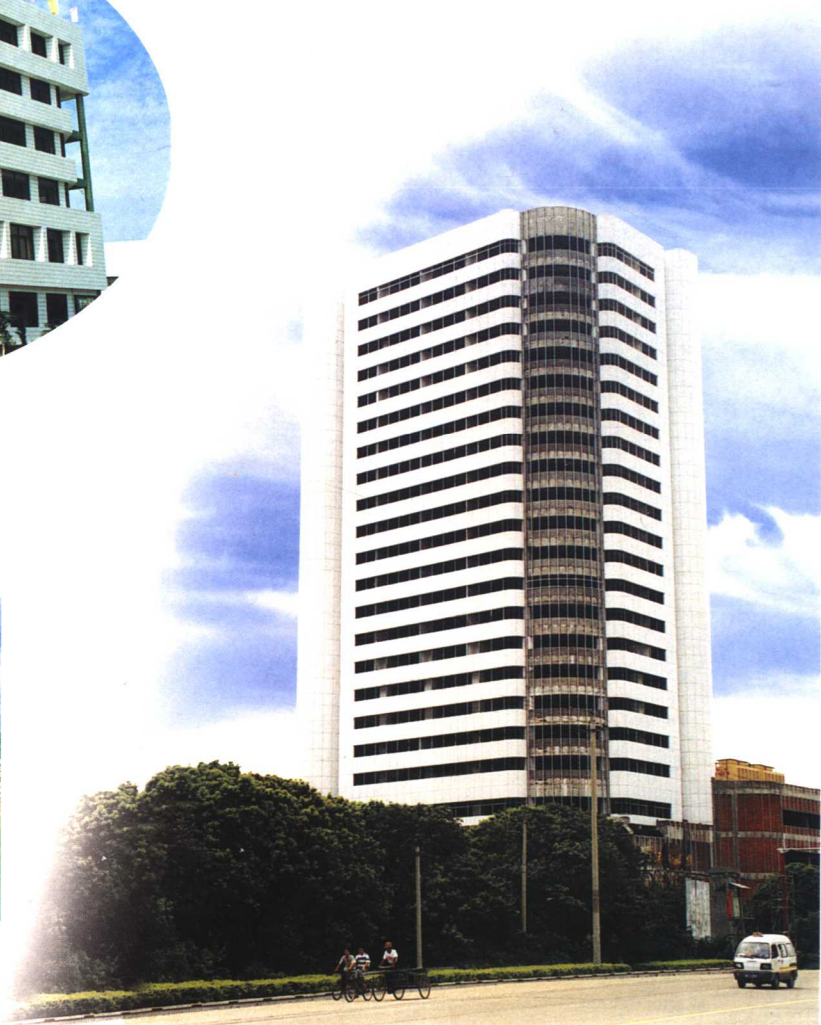
莆田邮政综合楼（23层）
