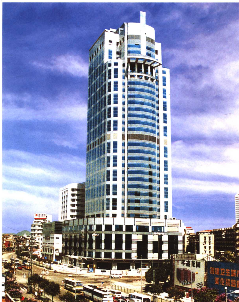
厦门商业银行中心大厦（市优 35层）
