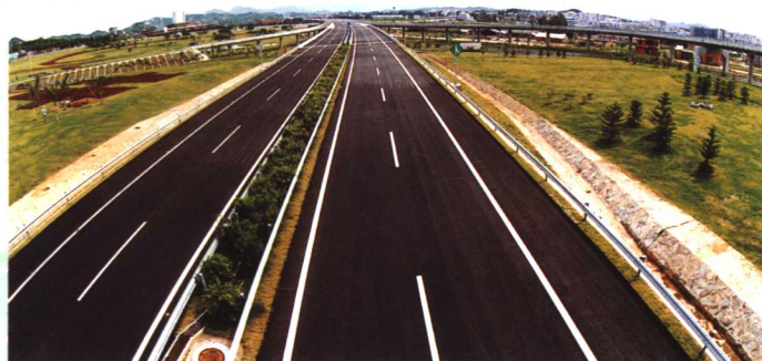
泉厦高速公路西福高架桥——省重点工程
