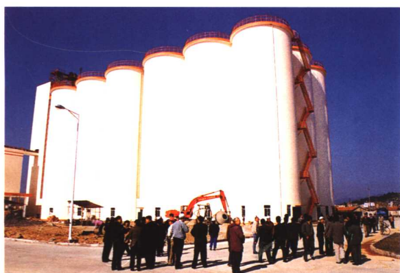
莆田秀屿中央直属粮库立筒仓——省重点工程
