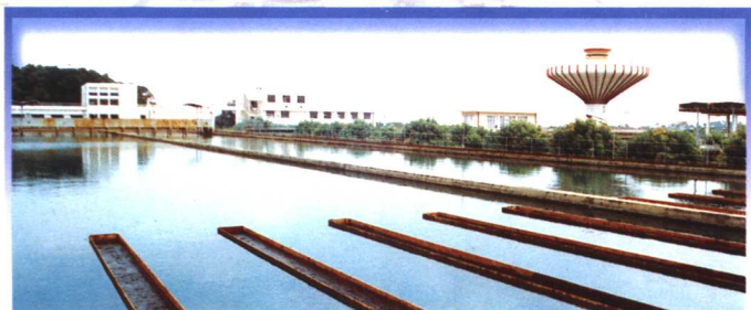
厦门高殿水厂（18万吨/日）
