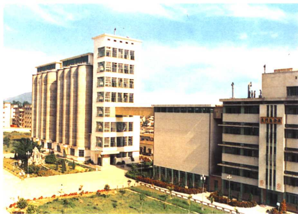
厦门面粉厂（1985年采用群体滑模施工）
