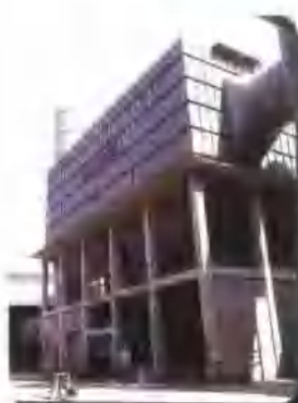
低压长袋脉冲除尘器
