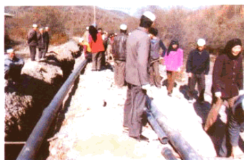
“人饮工程”管道铺设
