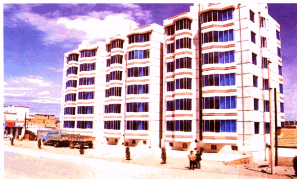
白音诺尔铅锌 矿林东镇内1号职 工住宅楼
