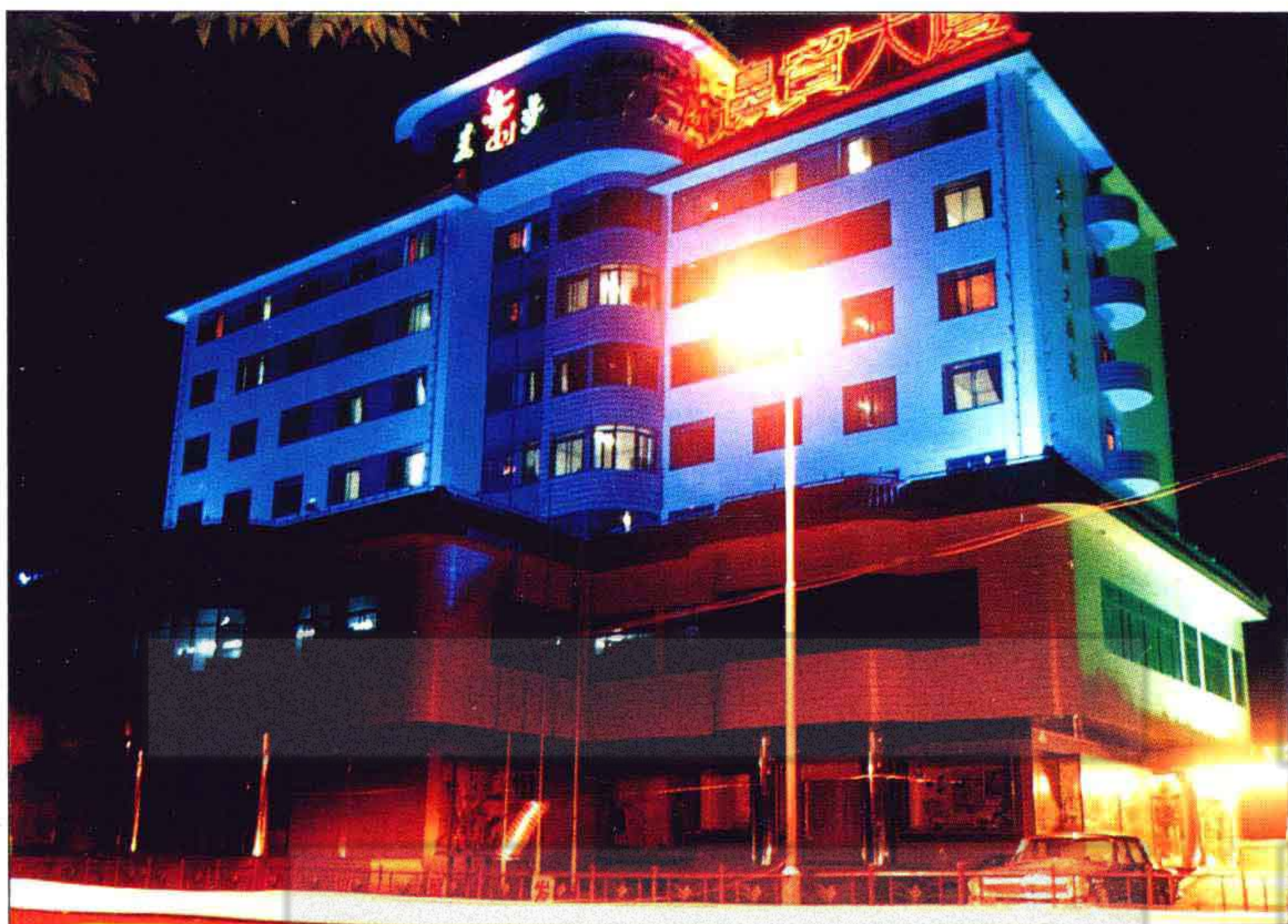
塔城华润集团总公司大厦主楼高九层,采用分层收缩的阶梯体形,三层的宽阔天台,组成高低错落的空中花园。
